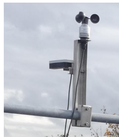
Fig 11 : Montage Anémomètre et sonde de pluie
